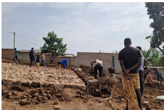
Ny parkeringsplads anlægges i overensstemmelse med krav fra myndighederne.
